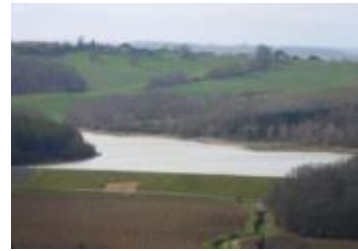
Aménagement retenue existante
