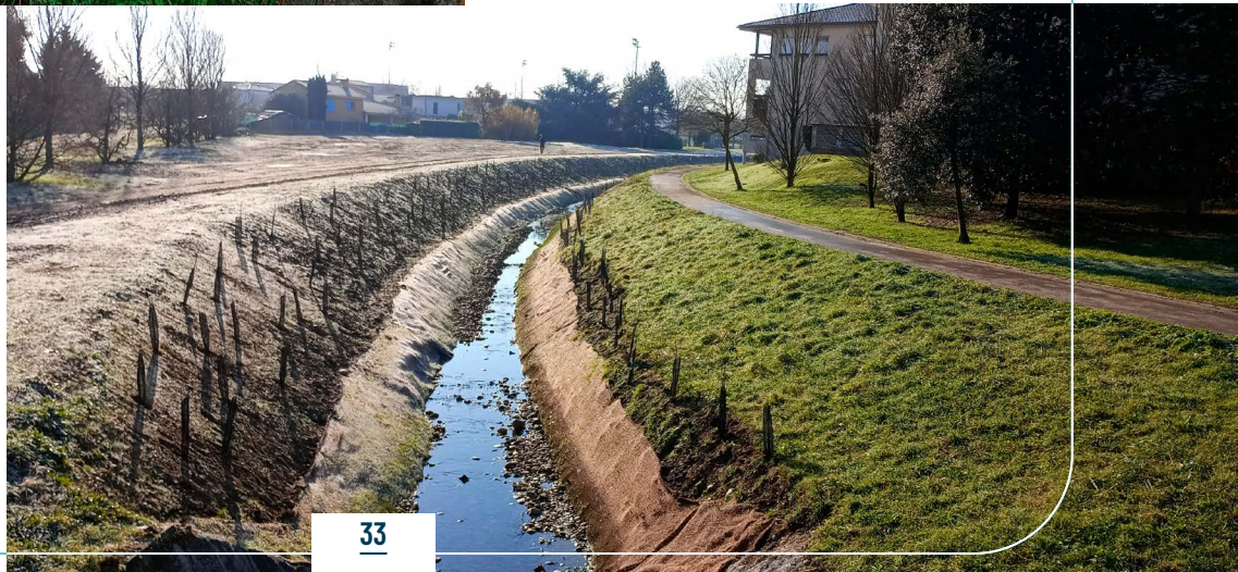
▼ Secteur 3 – Vue vers l'amont après travaux
