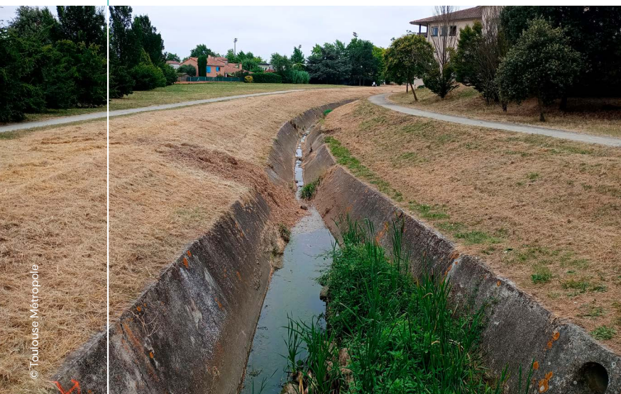
◀ Secteur 3 – Vue vers l'amont avant travaux
