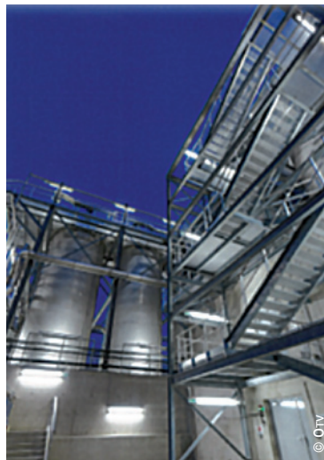
Silos de stockage
