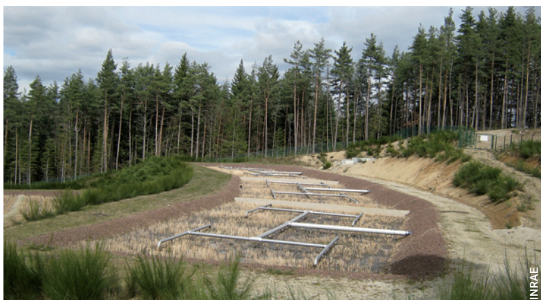
Premier étage de filtres plantés de roseaux en montagne lors de la saison hivernale
