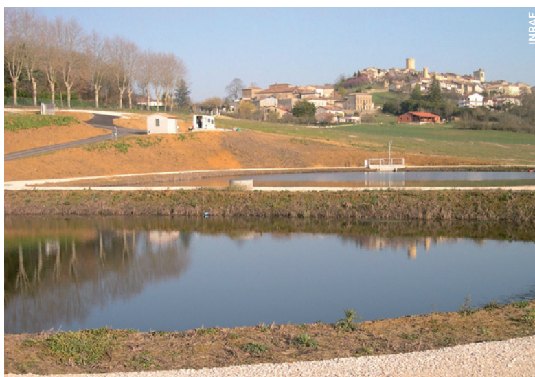
Station de lagunage naturel composée de deux bassins en série
