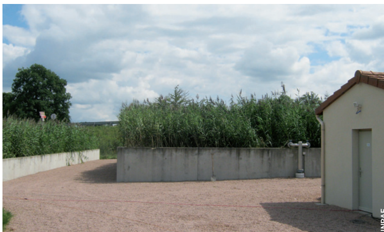
Lits de clarification-séchage implantés à la suite d'un lit bactérien
